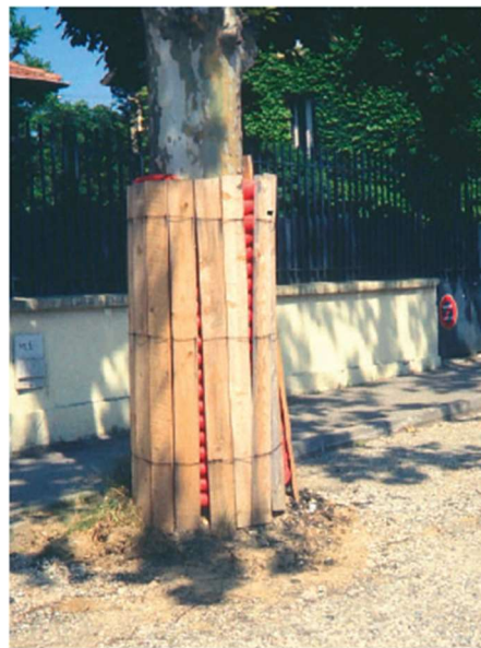
☞ Figures : Protection des arbres limitrophes au chantier
