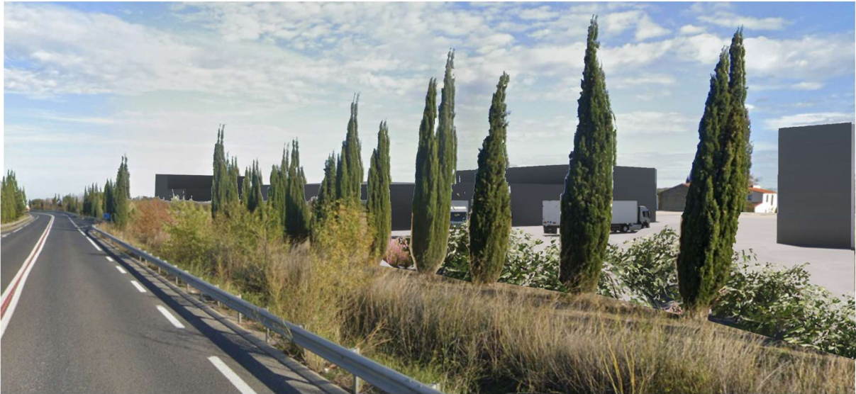
Intégration des volumes bâtis depuis la RD 900 avec le Mas Orlin en fond
